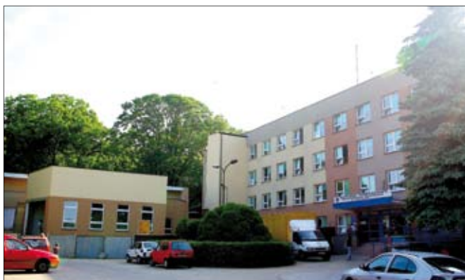
Szpital Powiatowy po przebudowie
