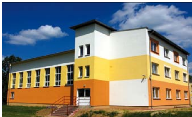
Nowy budynek MOW Kolonia Ossa
